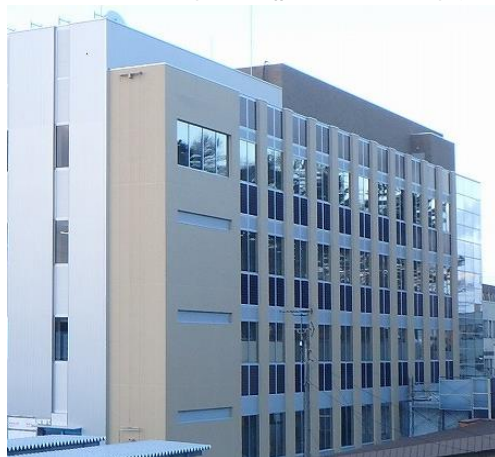
南側外壁に太陽光パネルを設置 北広島市役所
