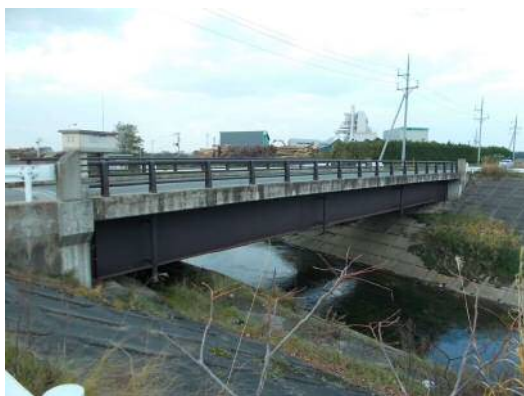
岩館猿賀線 北岡部橋
