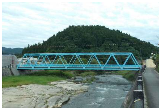
碓ヶ関古懸線 朝霧橋
