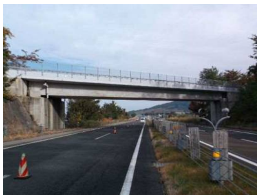
町居広船線 平賀三号橋
