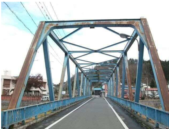
朝霧橋 初回点検時 (H23)
