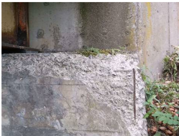
[杉館滝元橋 橋台]
