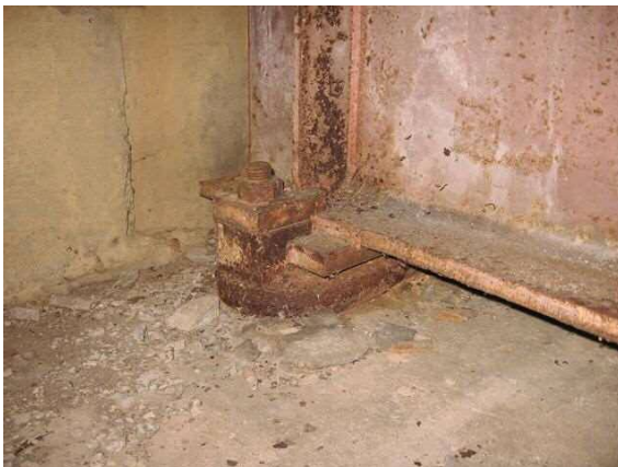
杉館橋 初回点検時 (H21)
