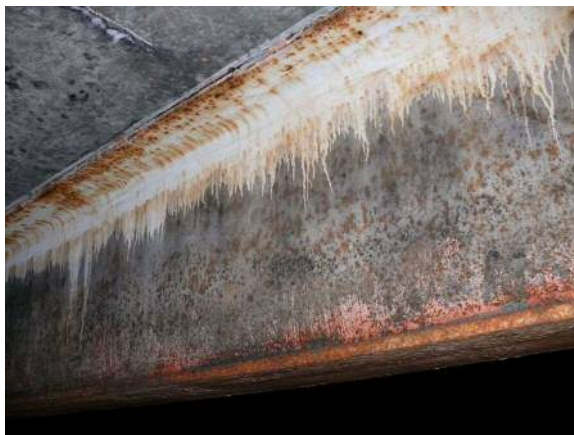
[御仮屋橋 主桁]
