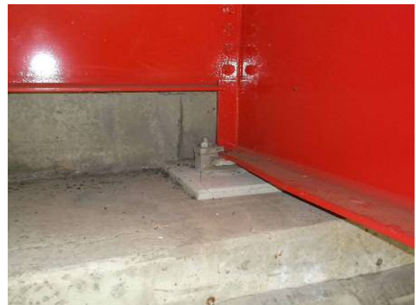
杉館橋 2 巡目点検時 (H29) [塗装塗替え・支承防錆処理ほか]
