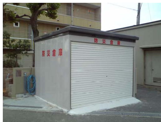
■資機材を保管している防災倉庫
