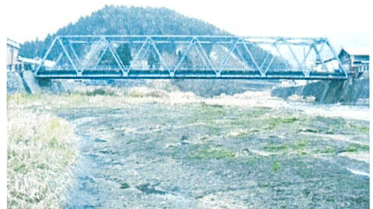
碓ヶ関古懸線 朝霧橋
