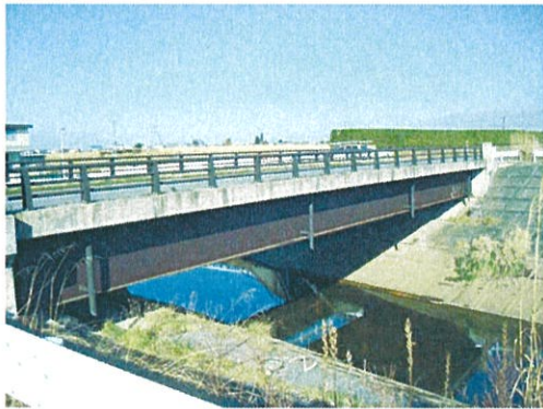
岩館猿賀線 北岡部橋
