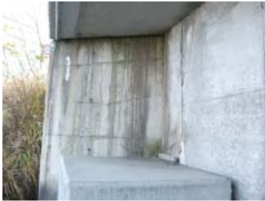
橋台：潜伏進展期(健全度4.0)
