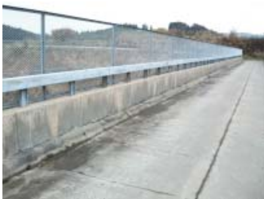
防護柵：健全度4.0
