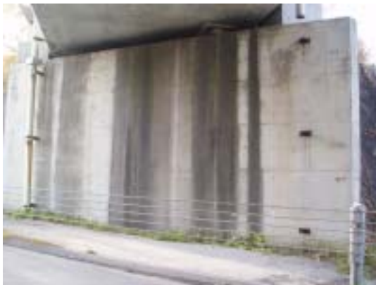
橋台：潜伏進展期(健全度4.0)
