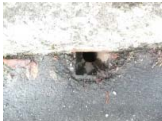
排水柵：健全度1.0
