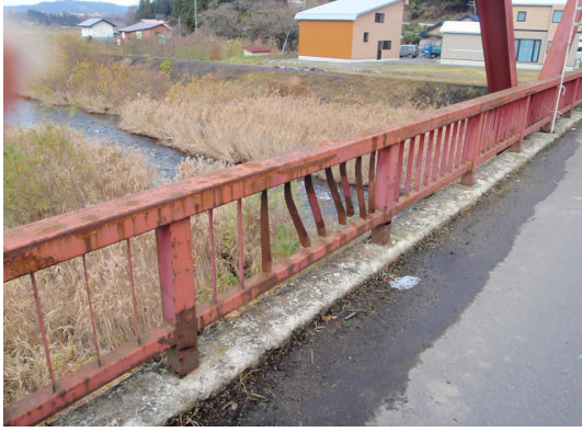
防護柵：健全度2.0
