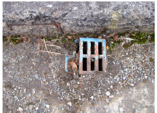
排水柵：健全度2.0
