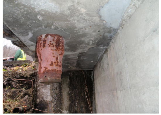
排水管：健全度1.0
