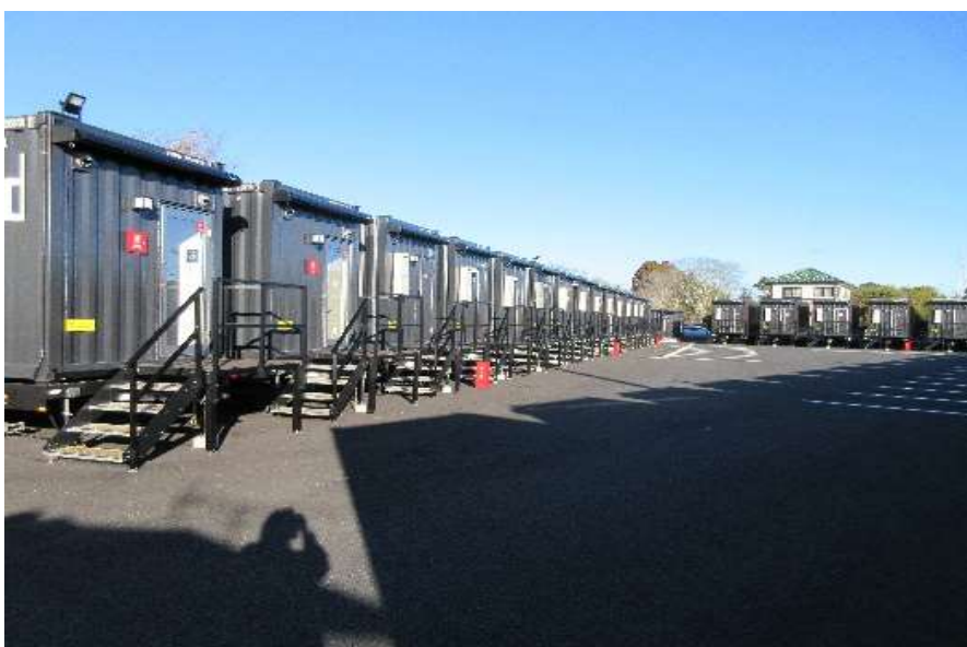
コンテナホテルの外観
