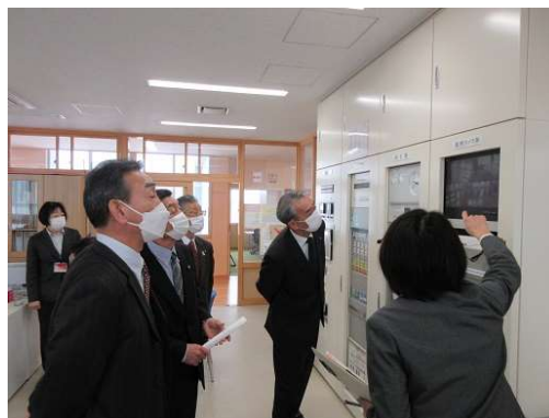
職員室内の防災監視盤を調査
