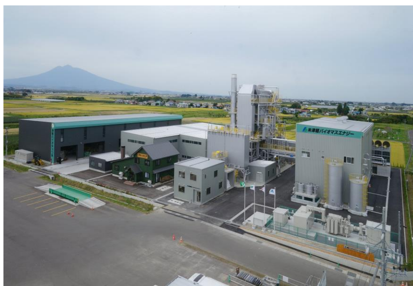
津軽バイオマスエナジー
