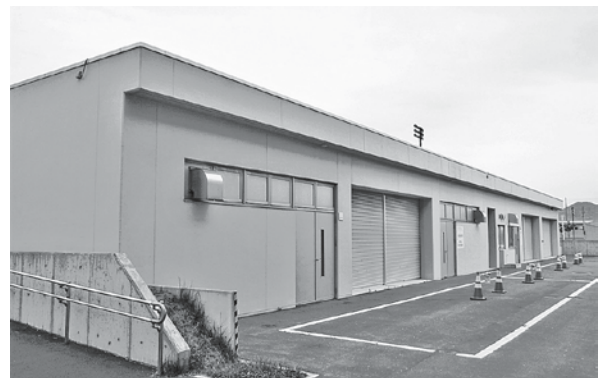
市の防災備蓄倉庫
