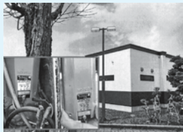
調査した照明設備
