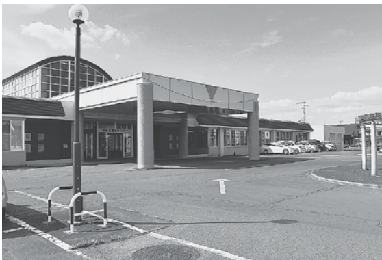
新本庁舎の開庁後は、現在の健康センター内にある福祉関係課は本庁舎に移転します。
