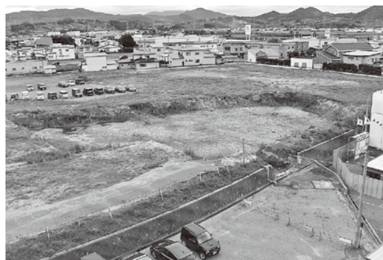
新本庁舎建設予定地（旧平川診療所跡地）。令和2年度の着工、令和4年度の開庁予定。
