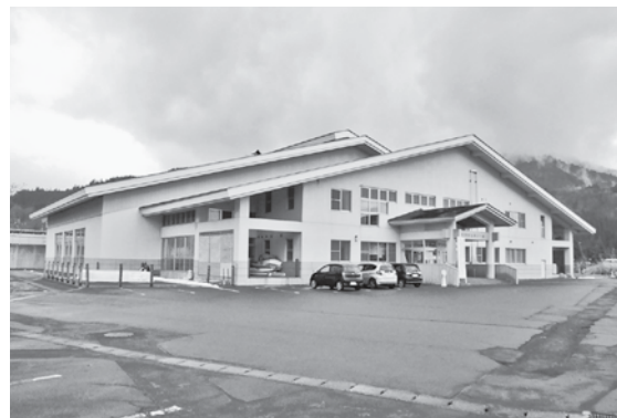
碓ヶ関地域の屋内プールゆうえい館。日本水泳運動連盟公認プールとして公式競技なども開催できます。
