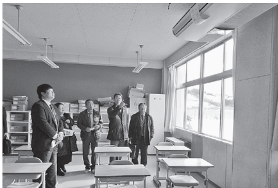
平賀東中学校に設置された冷房機器。教育民生常任委員会で調査しました。（※関連記事P5下欄）
