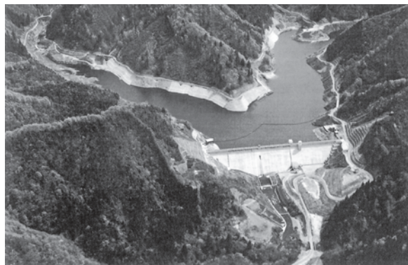
碓ヶ関地域と大鰐町に給水している久吉ダム。
