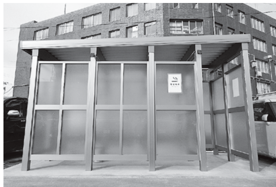
本庁舎裏に新たに設置された喫煙所。
