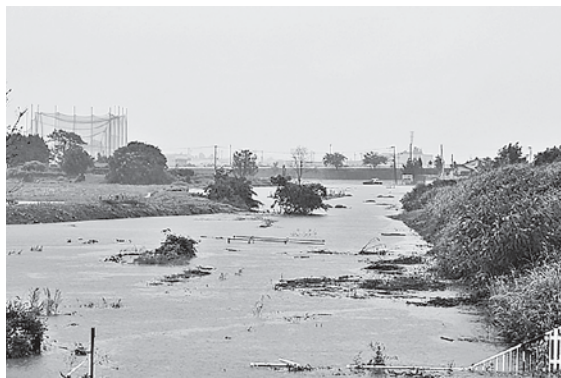
平成25年9月の台風18号による日沼地区浸水被害の様子。
