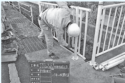
転落防止柵の整備工事
