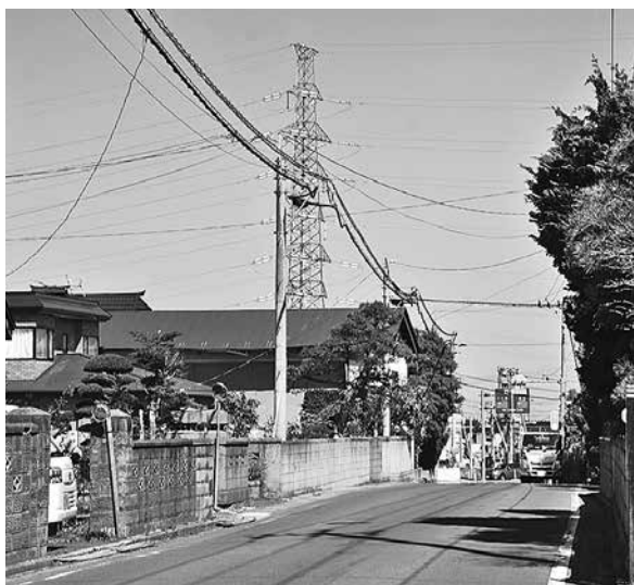
危険な箇所が多い吹上地区の道路。
