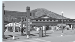
大規模改修が予定されている道の駅いかりがせき
