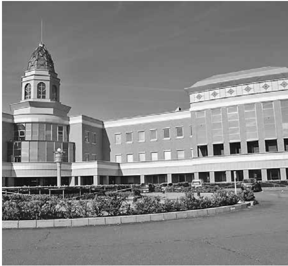
平成10年に竣工された尾上庁舎。
