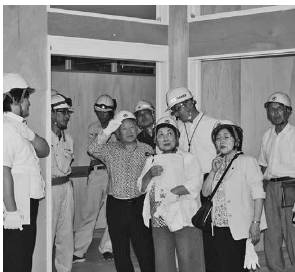
平賀東小学校の改築工事を教育民生常任委員会が視察しました。
