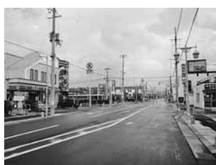
平賀駅前 電線の様子
