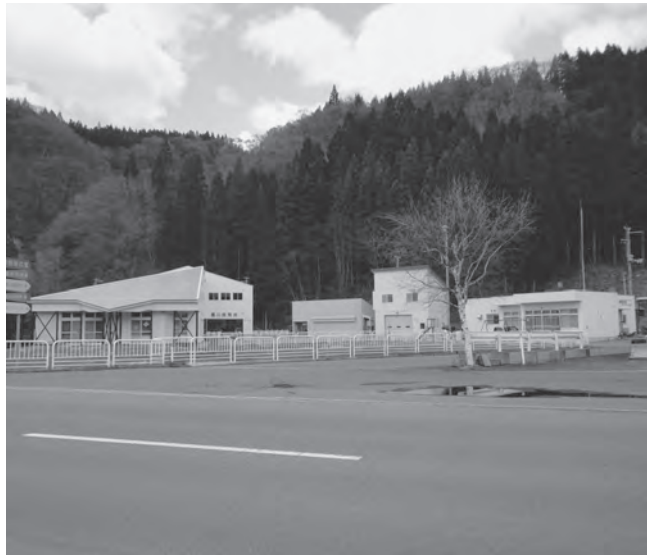
地域住民の利便性を考えた施設活用が求められる現在の葛川支所付近。
