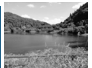
▲津刈ダム 底には泥がたまっており、水位はあまりない
