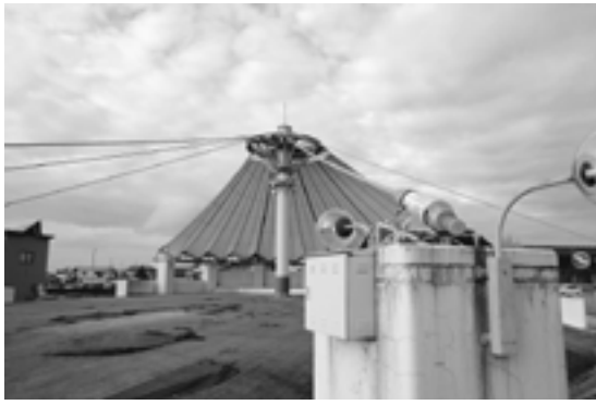
イベント広場（おのえスポーツセンター内）床ははがれてぼろぼろになっている。老朽化が進み、入口にはロープが張られ使用禁止となっている。
