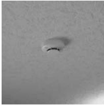
天井に取り付けた火災警報器：平成16年の消防法の改正により、全住宅について住宅用火災警報器の設置が義務化された。新築の住宅は平成18年6月1日まで、既存住宅については平川市火災予防条例により、平成20年の6月1日までに設置することとなっていたが、いまだに設置率は低い。
