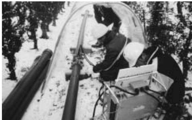
八幡崎地区の水道管布設工事の様子(融雪作業)
