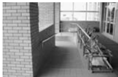
玄関車いす用スロープ
