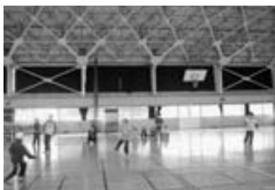
体育館上部窓部分鉄筋によるブレス補強 （写真は2ヵ所）
