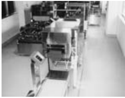
平賀学校給食センター炊飯室：連続炊飯システムで炊飯はガス方式で、米から釜の洗淨まで自動化されている。
