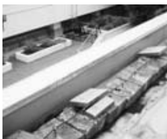
碓ヶ関公民館屋上 工事現場
