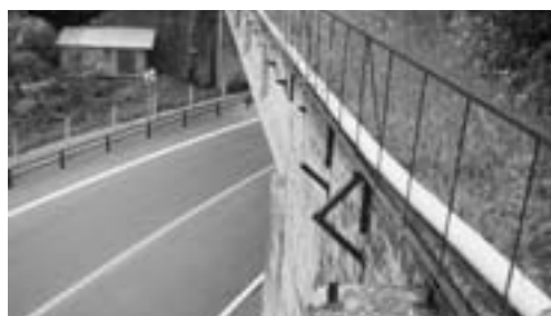
つがる湯ノ沢高架橋（昭和50年国有鉄道より無償譲渡）と下を走る国道7号線
