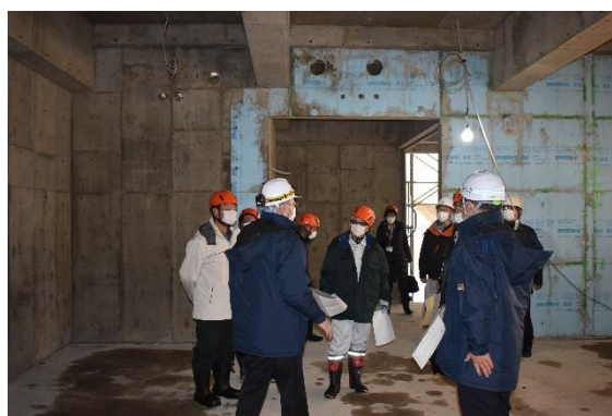
建設中の道路情報館の工事進捗状況を調査
