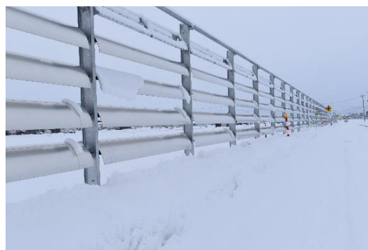
調査した新山国道線防雪柵
