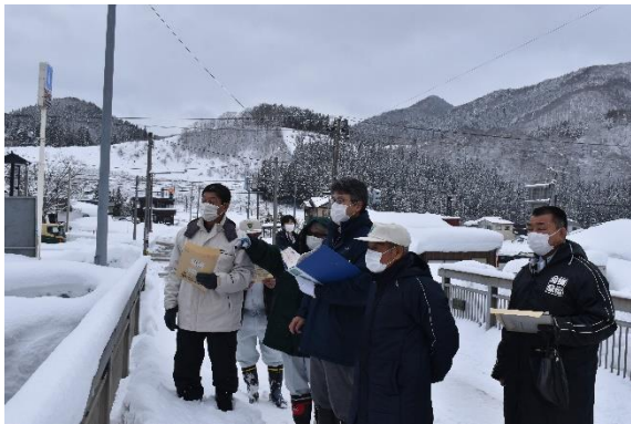
橋から工事の状況を確認
