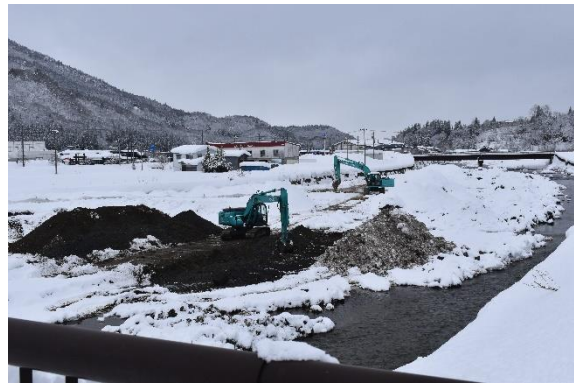
平川の河床掘削の現場
