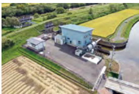
(三好排水機場)
