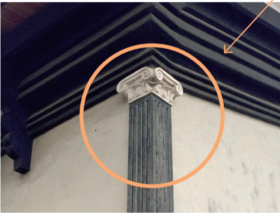
古代ギリシヤ建築のイオニア式に相似する柱。渦巻き型の柱頭に細身の柱が特徴
