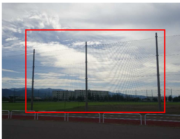
②東側防球ネットポール
